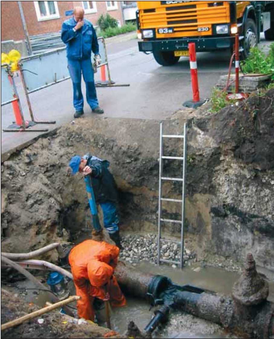
Figur 1. Renovering af ledningsnettet i Grenaa.
